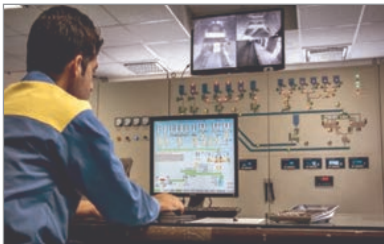
شکل ۲۸- اتاق فرمان (کارخانه شیشه اردکان)
